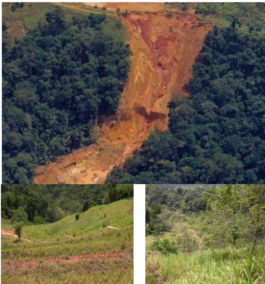
Figuras 5.7 a 5.9 : Sequência de fotos mostrando o talude degradado devido à deficiência de drenagem (no alto); após terraplenagem e aplicação de grama (à esquerda), após o crescimento da cobertura vegetal (à direita)
