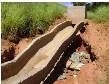
Figuras 5.1 e 5.2: Canaletas de concreto danificadas e dispositivo de drenagem superficial utilizando materiais naturais
