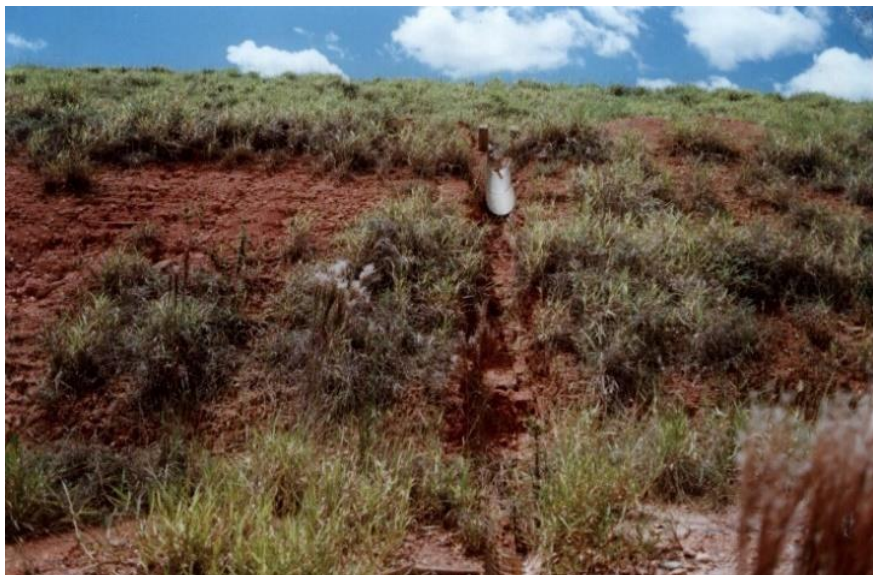
Figura 5.6: Pilha com drenagem em canaleta de concreto rompida
