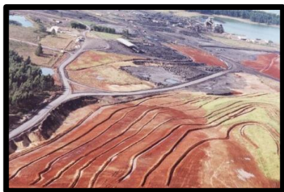
Implantação do sistema de drenagem pluvial
