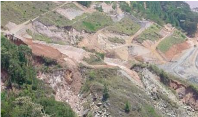
Figura 5.5: Pilha com erosões generalizadas e processos de instabilização de taludes em desenvolvimento
